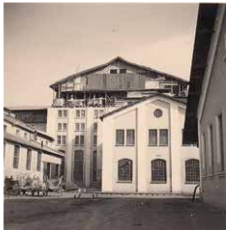
Wiederaufbau der Hauptbetriebshalle der Zuckerfabrik Brenndorf, die beim Erbeben vom 19. November 1941 zerstört wurde.
