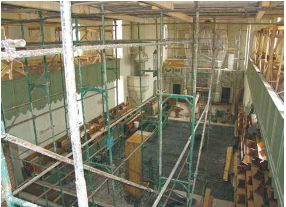
Im März 2013 wurde das Gerüst aufgebaut, um die Saaldecke zu erneuern.
