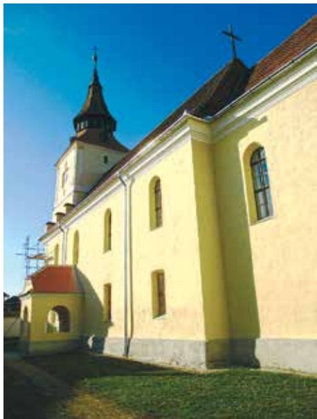
Die Südfront der Kirche wurde 2017 erneuert.
