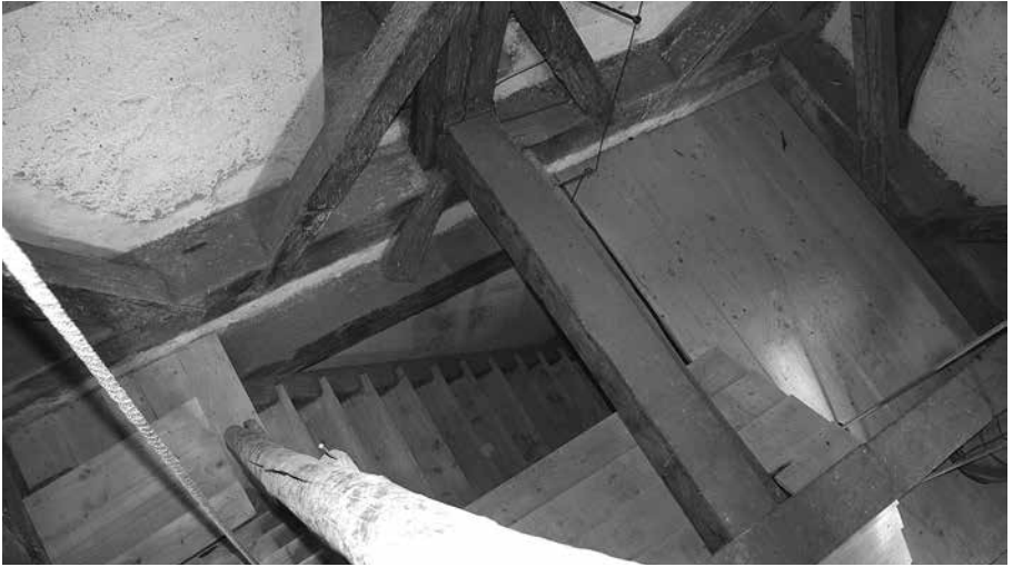
Die Fußböden im Inneren des Turmes wurden mit neuen Brettern verdoppelt.
