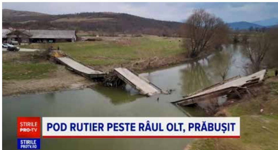
Der rumänische Fernsehsender ProTV berichtete über den Einsturz der Alt-Brücke zwischen Brennendorf und Erösd (Bildschirmfoto).
