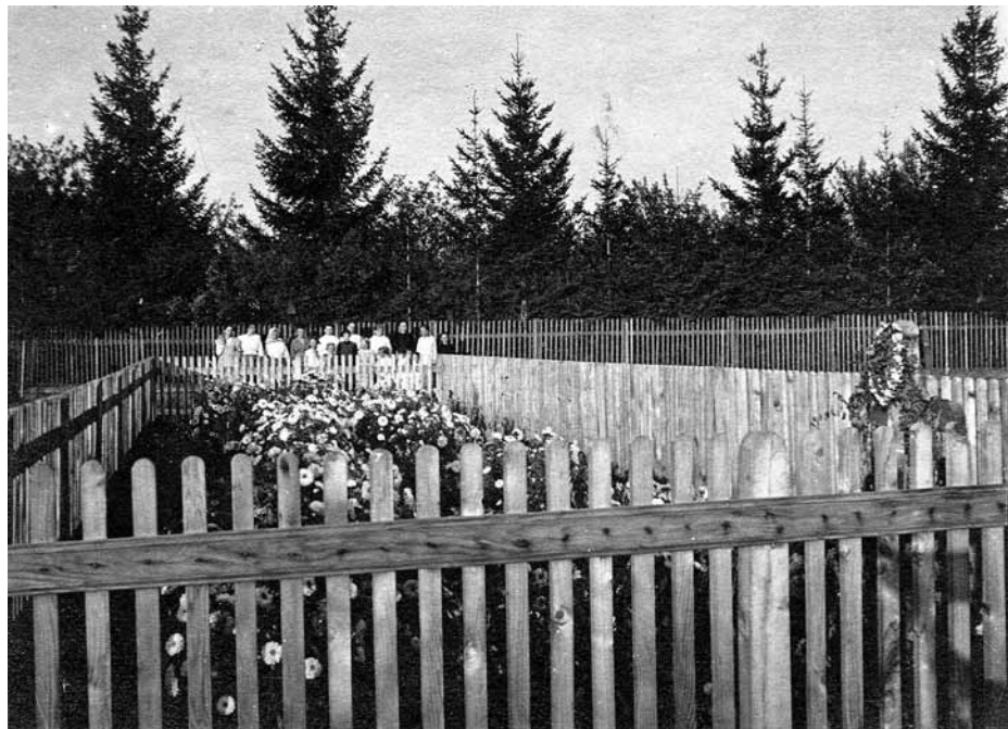
Das provisorischen Heldengrab von 1916, in welchem die 25 deutschen Soldaten auf dem Gelände des neuen Friedhofes in Brenndorf eingesetzt wurden.
